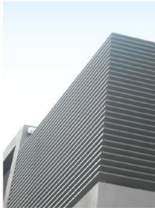
Air Louvers – Ventilation Louvers
